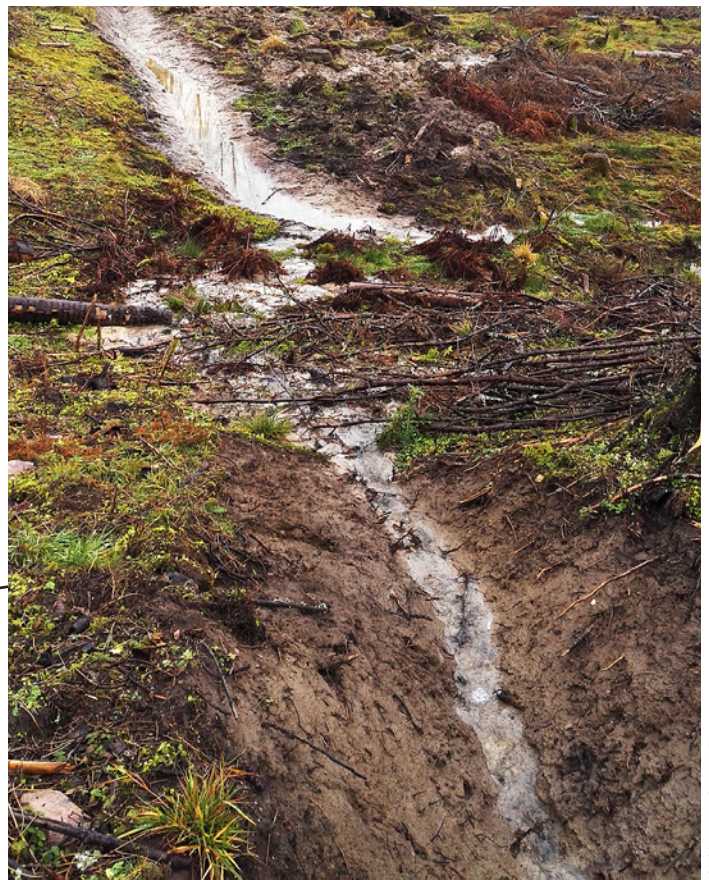
Figur 3. Ett sätt att minska transporten av partiklar är att göra avbrott och förskjuta fortsättningen på skyddsdiket. Vattnet översilar då från det ena till det andra diket.
